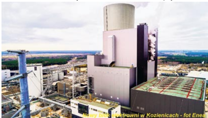
Nowy blok elektrowni w Kozienicach - fot. Enea
