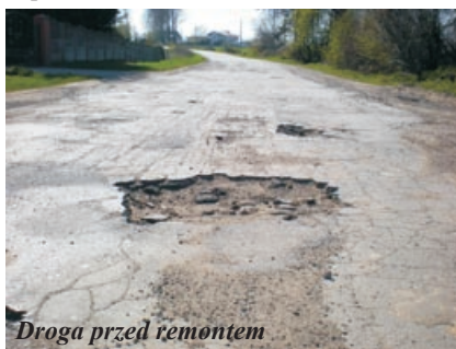
Droga przed remontem
